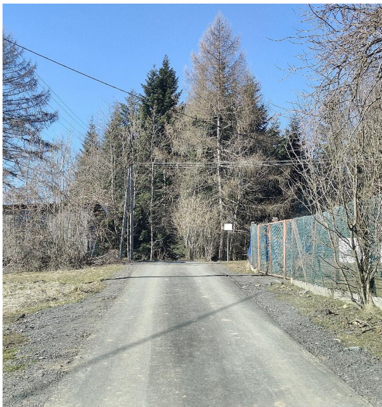
Żarnówka Matyje Górne, remont drogi, nawierzchnia asfaltowa
