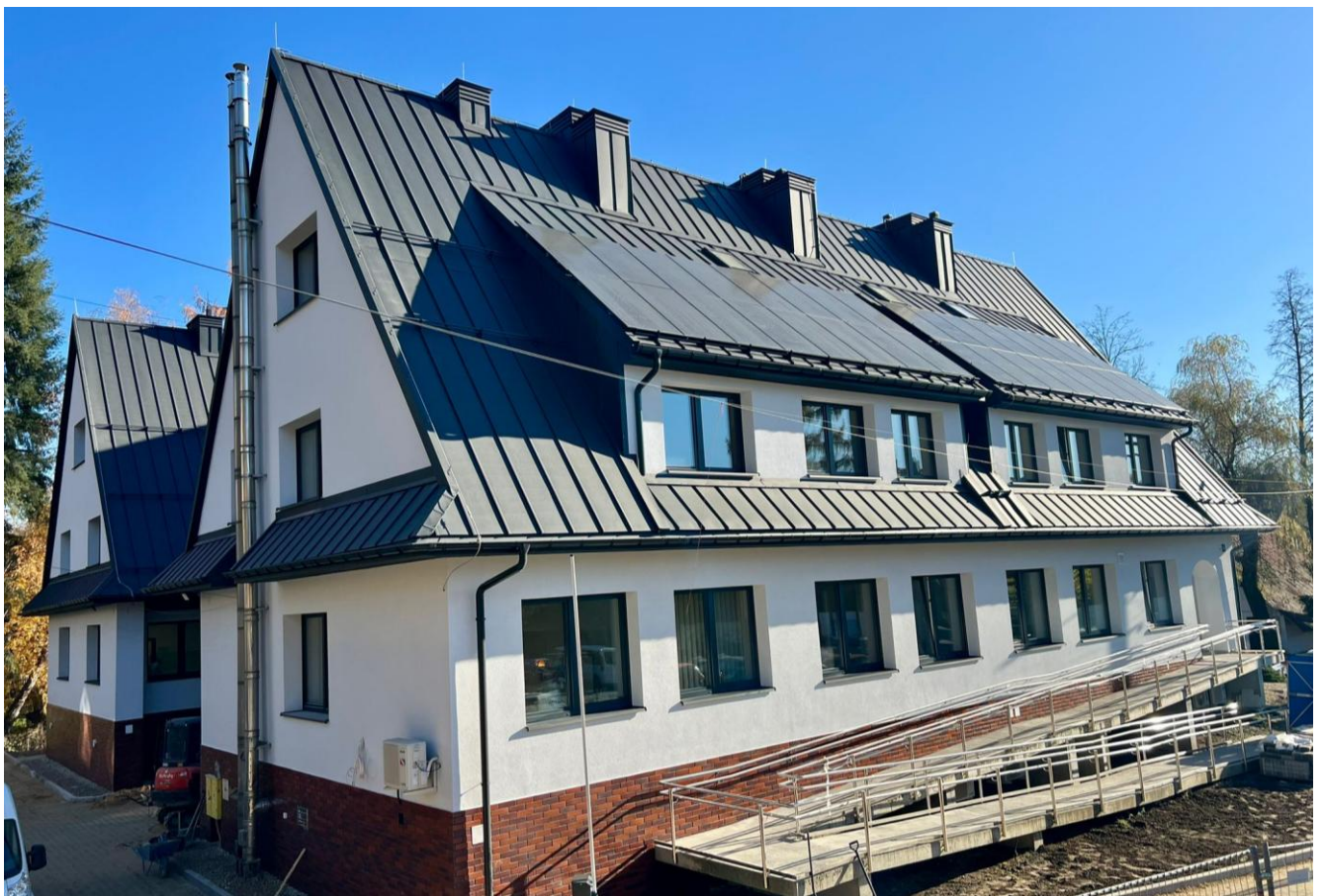
Miejska Przychodnia Zdrowia w Makowie Podhalańskim po modernizacji. Źródło: Urząd Miejski w Makowie Podhalańskim.
