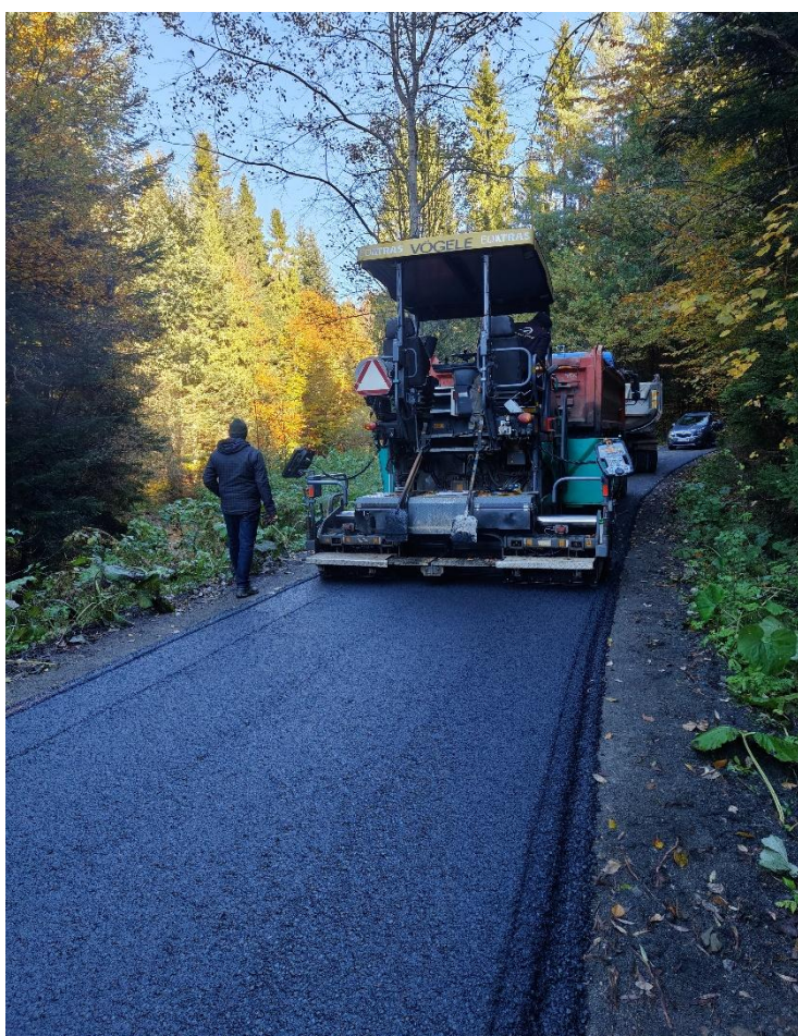
Grzechynia Carhla Drwałówka, remont drogi, nawierzchnia asfaltowa
