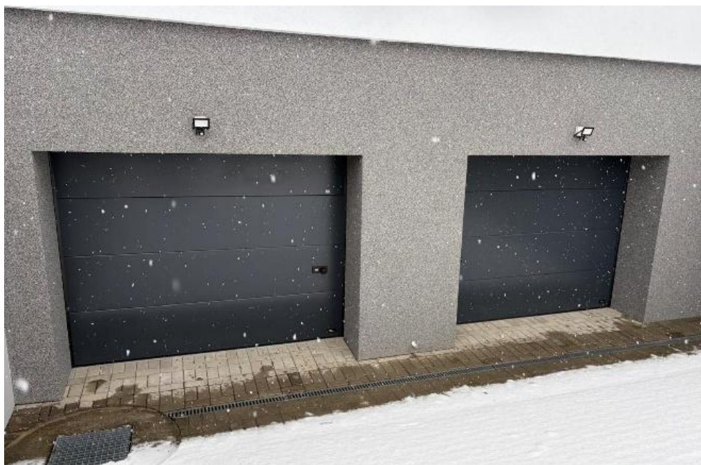
Modernizacja pomieszczeń garażowych oraz zakup nowych bram garażowych w WOZ w Juszczyne. Źródło: Urząd Miejski w Makowie Podhalańskim.
