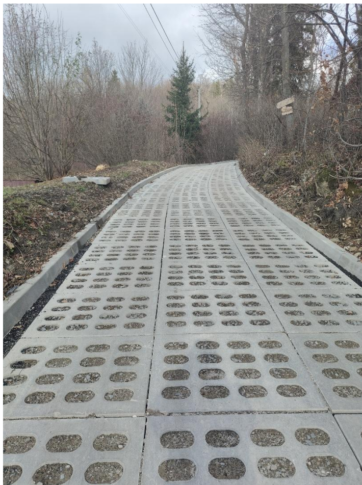
Maków Podhalański ul. Widokowa, remont nawierzchni, płyty betonowe
