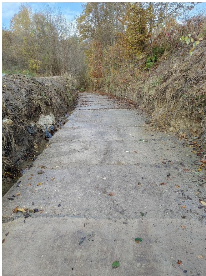
Maków Podhalański ul. Piasta, remont nawierzchni, płyty betonowe
