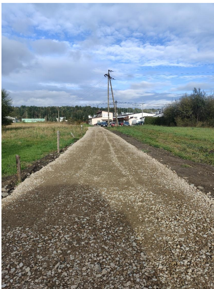
Białka Czajowa remont drogi, nawierzchnia z kruszywa
