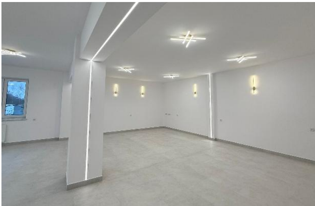
Zmodernizowane pomieszczenia budynku Filii Biblioteki w miejscowości Żarnówka. Źródło: Urząd Miejski w Makowie Podhalańskim.
