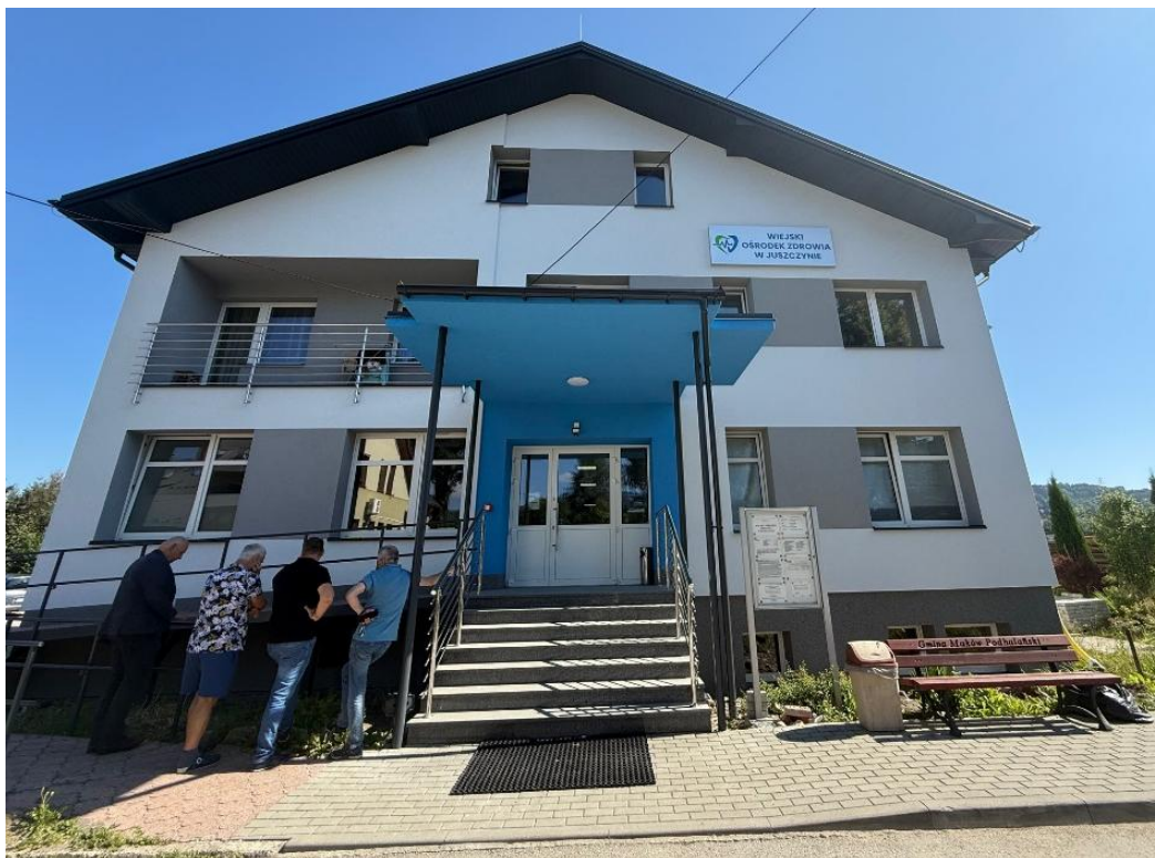
Wiejski Ośrodek Zdrowia w Juszczyne po modernizacji. Źródło: Urząd Miejski w Makowie Podhalańskim.
