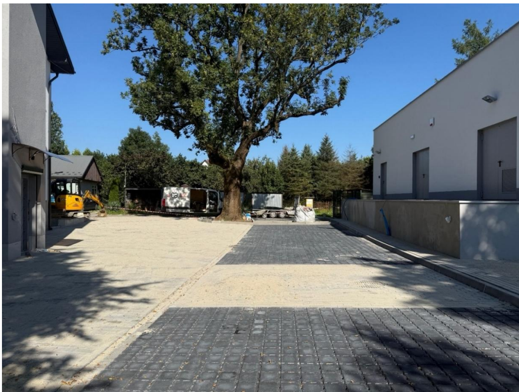
Wiejski Ośrodek Zdrowia w Juszczyńce po modernizacji. Źródło: Urząd Miejski w Makowie Podhalańskim.
