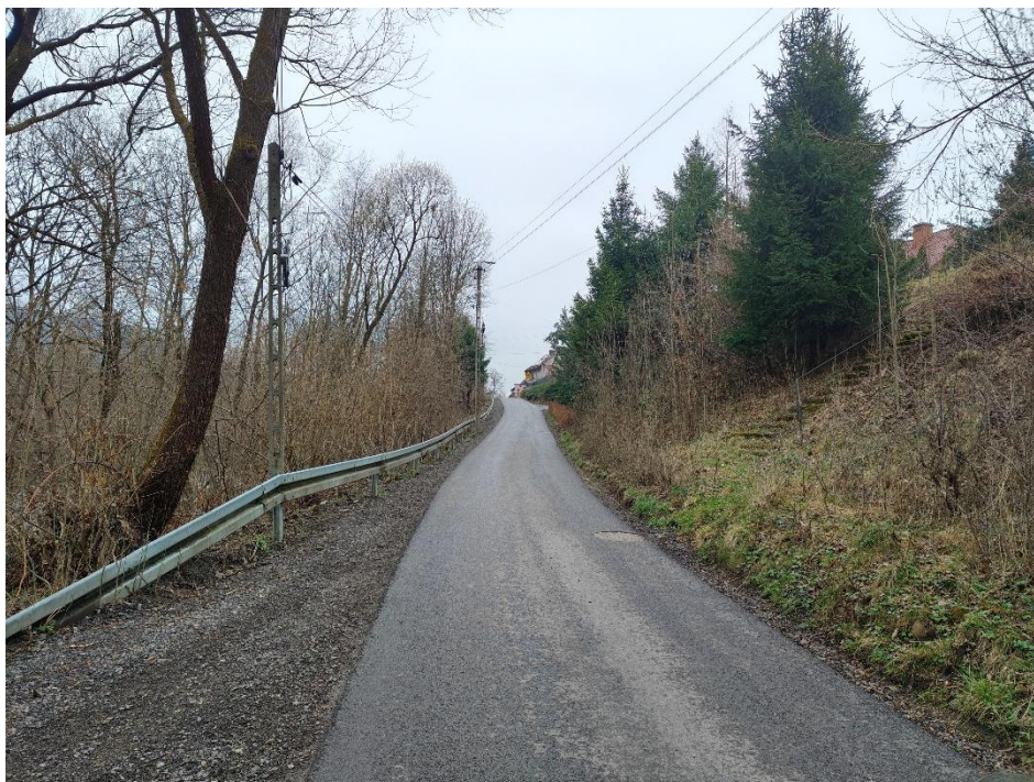
Białka Pawłówka remont drogi, nawierzchnia asfaltowa
