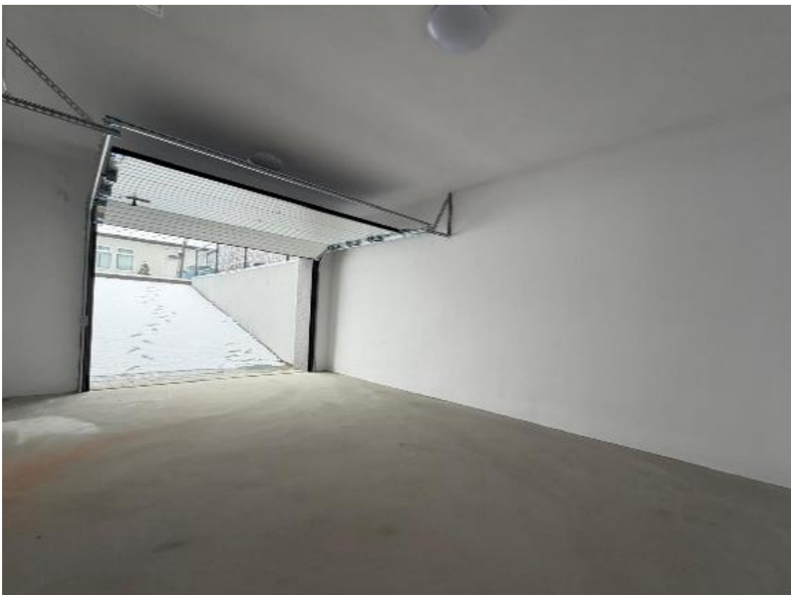
Modernizacja pomieszczeń garażowych oraz zakup nowych bram garażowych w WOZ w Juszczynie. Źródło: Urząd Miejski w Makowie Podhalańskim.
