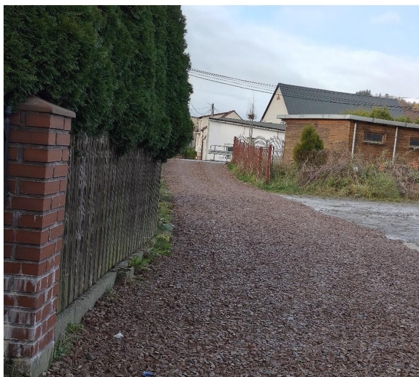
Maków Podhalański ul. Żwirki i Wigóry – boczna, remont drogi, nawierzchnia z kruszywa
